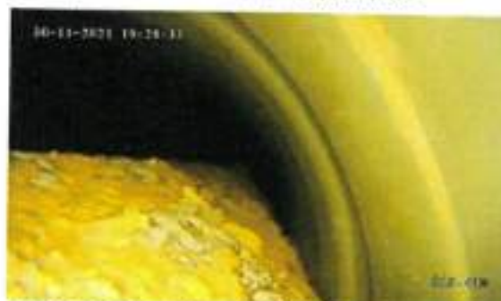
Fondo pozzo con depositi (-35.5 m)
