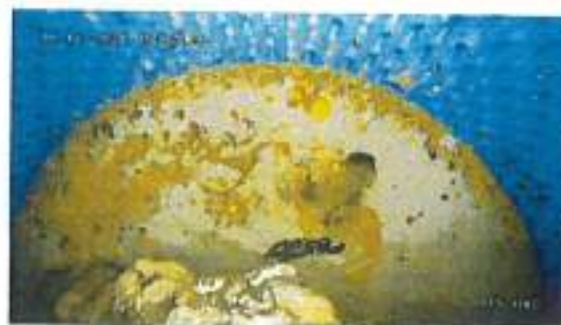
8, 00:17:02, 35.00m Ostacolo, / depositi duri presenti sul fondo
