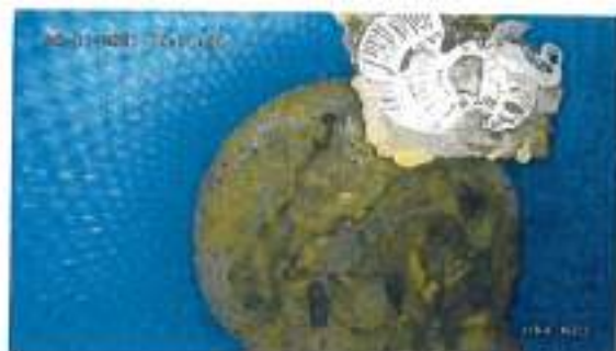
7, 00:17:02, 35.00m Ostacolo, / depositi duri presenti sul fondo
