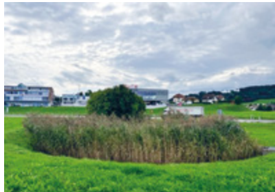
Die «gewässerschutztechnische Anlage Sirnach» beim Autobahnzubringer. Bild: zVg
