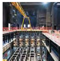
La machinerie du Grand Théâtre va être remplacée
