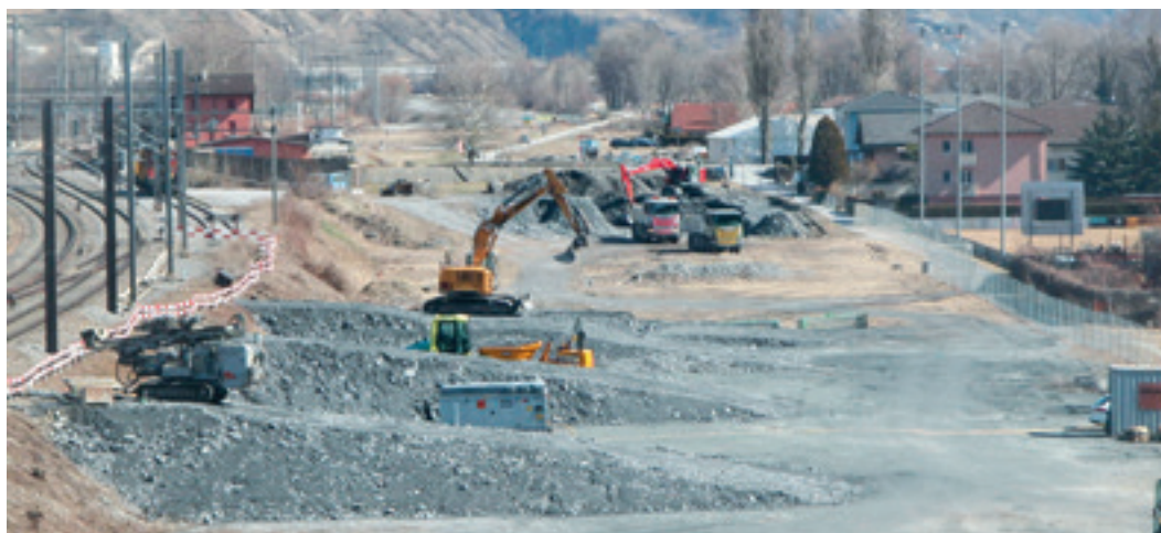
Bauarbeiten haben am 12. März begonnen:
