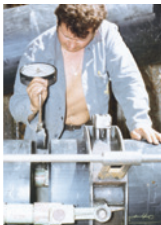
Leo bei seiner Arbeit als Heizungs- und Lüftungsmonteur in Basel
