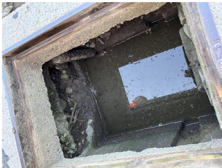
Grille de récolte des eaux avec état de stabilité alarmant (vides au niveau de la structure porteuse de la chaussée)
