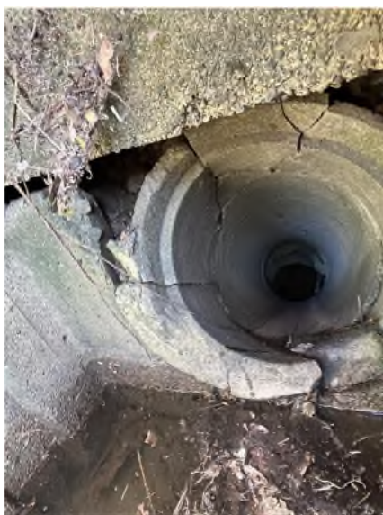
Grille de récolte des eaux avec état de stabilité alarmant (vides au niveau de la structure porteuse de la chaussée)
