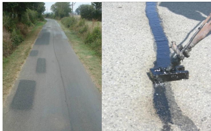
Application d'un patch à gauche, pontage à droite
