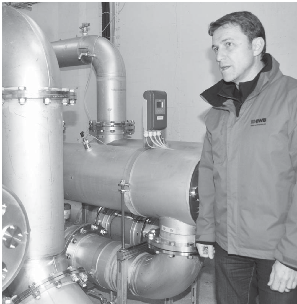
Niklaus Müller erklärt die Funktionen der neuen Niederdruck-UV-Trinkwasserentkeimungsanlage im Rahmen der ISO-Zertifizierung.
