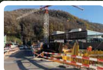
Ponte Via Industria
