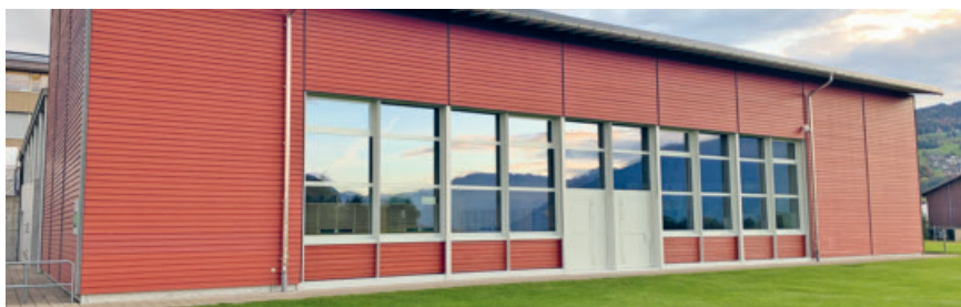
■ Neu sanierte Fensterfront Mehrzweckhalle Ernetswil.
