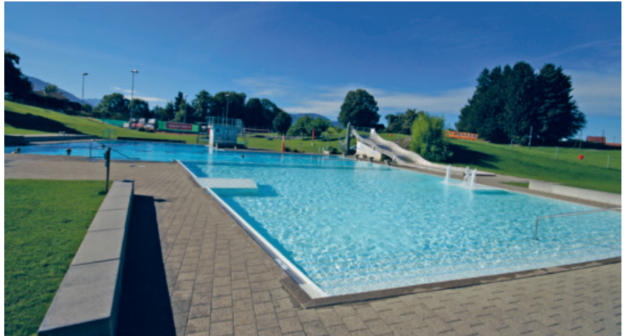
■ Die Folie im Hauptbecken muss nach 20 Jahren ersetzt werden.
