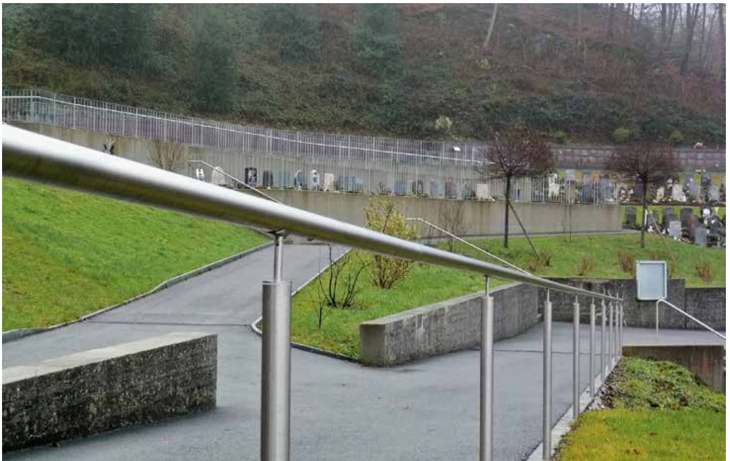
Neues Geländer zur Sicherung des Gehwegs auf dem Friedhof.
