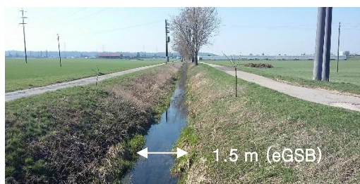
Abb. 13 Beispiel einer Berechnung der natürlichen Gerinnesohlenbreite
