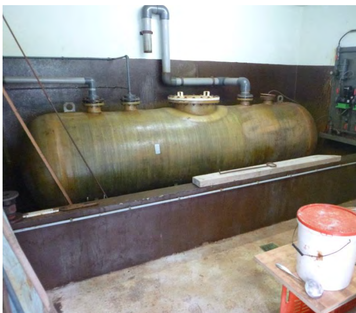
Figure 11 Photo de la citerne de 3000 L de chlorure ferrique (à gauche) et de la cuve de pompage intermédiaire (à droite)
