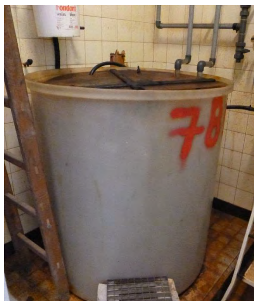
Figure 11 Photo de la citerne de 3000 L de chlorure ferrique (à gauche) et de la cuve de pompage intermédiaire (à droite)
