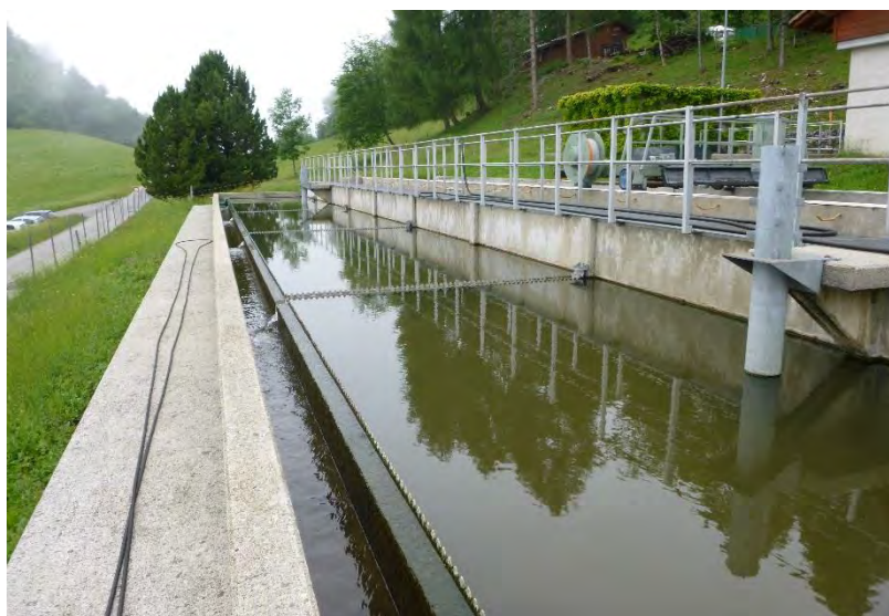
Figure 9 Photo du décanteur secondaire
