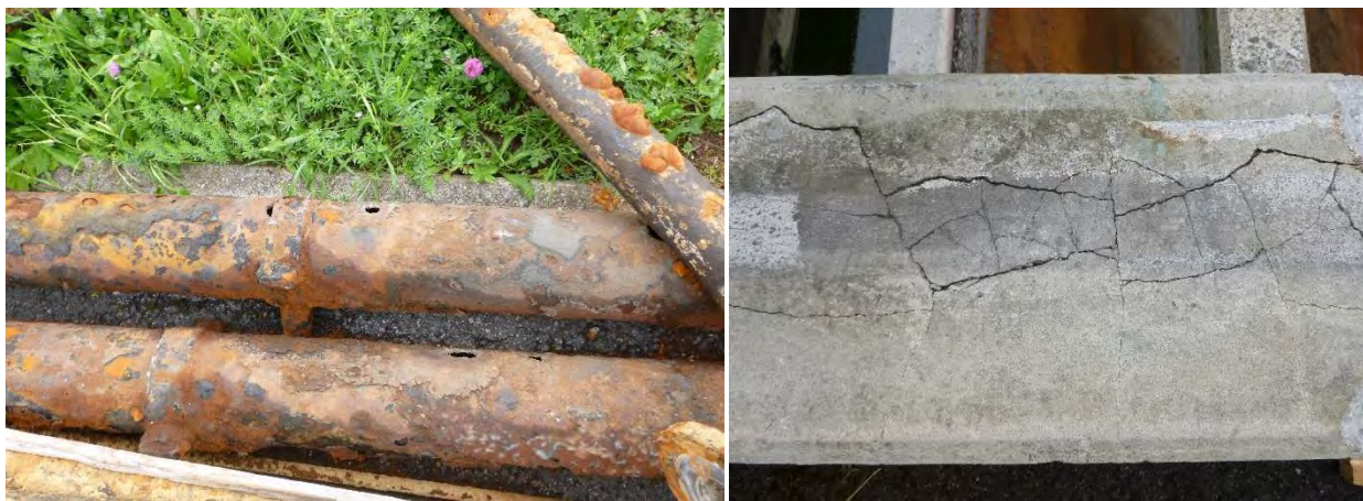
Figure 13 Photo des anciennes conduites de récupération des boues dans le décanteur primaire (à gauche) et de la bande de roulement du pont roulant du décanteur primaire (à droite)
