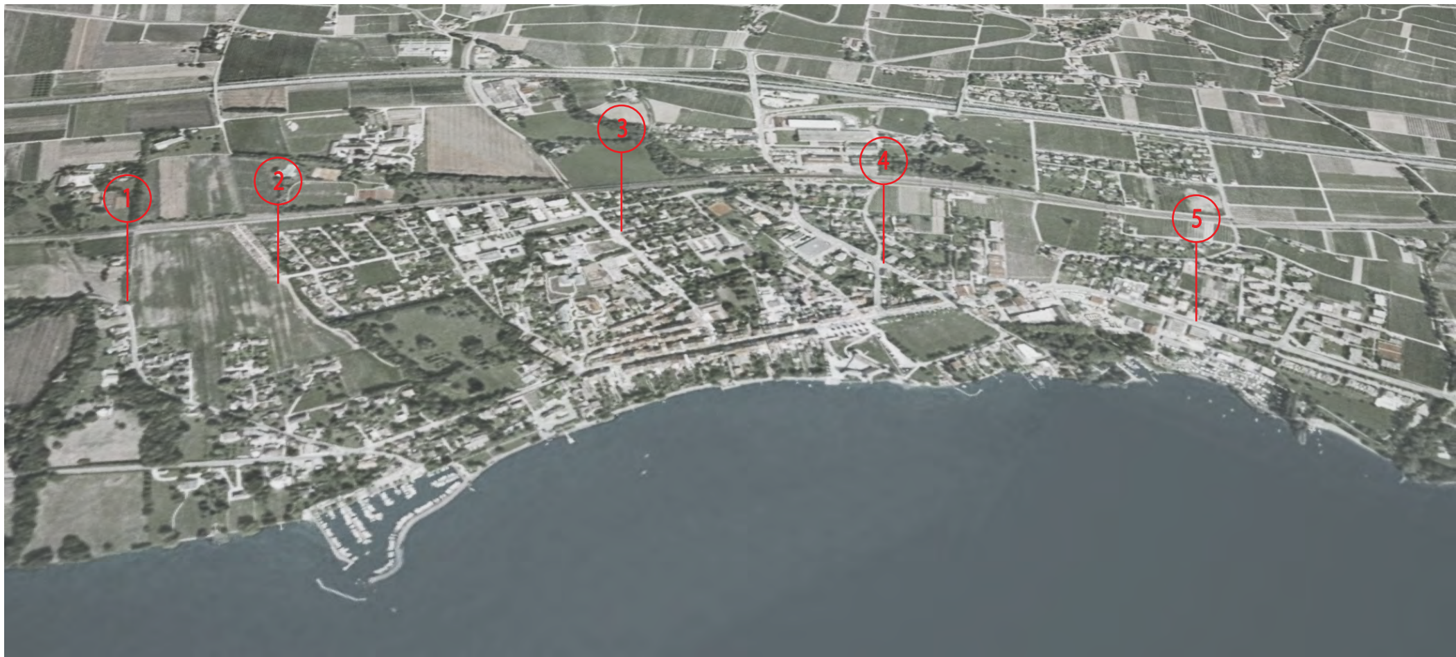
Situation générale des différents types d'éclairage routier
