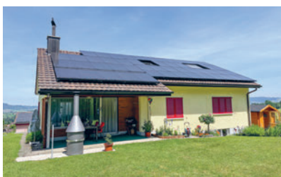
80,4 Quadratmeter Solarpanel liefern eine Spitzenleistung von 15 Kilowatt.
