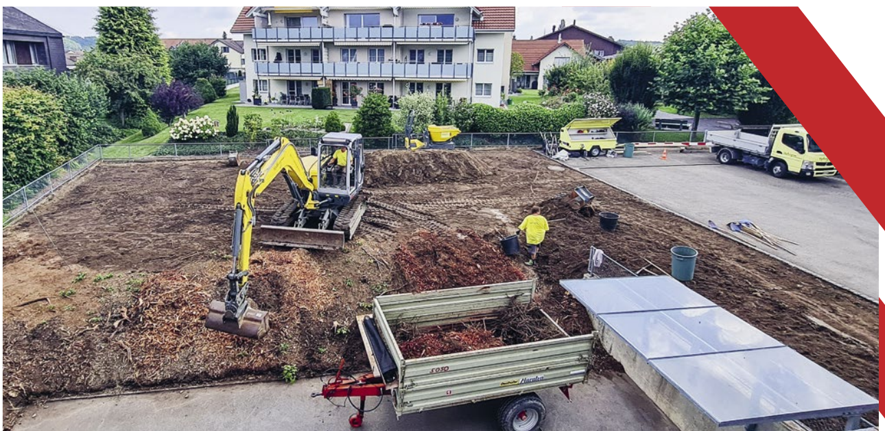
Bauarbeiten für die neue, naturnahe Gartenanlage beim Gemeindehaus.
