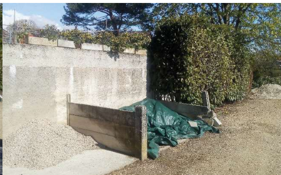
Photo 2 – Murets à refaire
