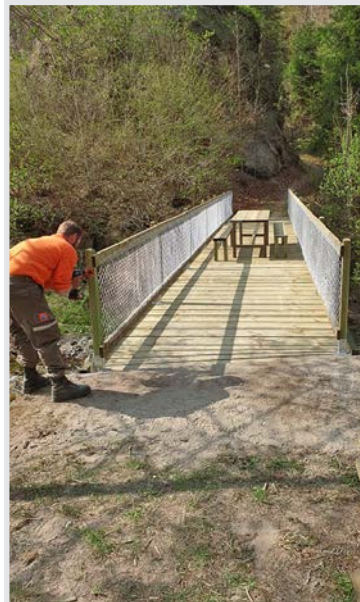
Arbeiten an der Munisteinbrücke, Zivilschutz
