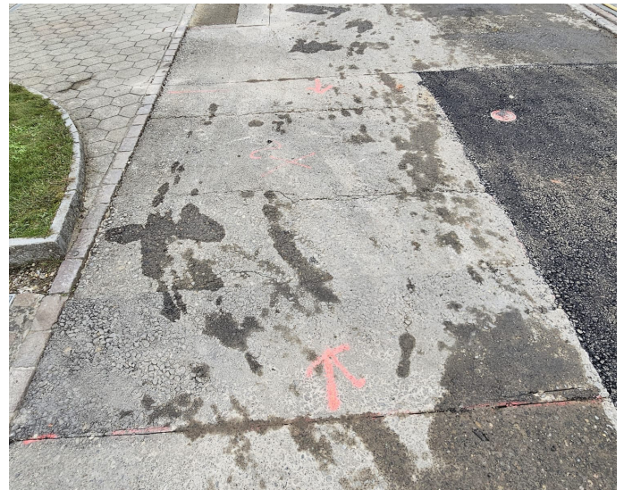
Diverse Stellen der Tragschicht mussten ersetzt werden
