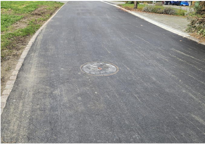
Deckbelag fertig eingebaut
