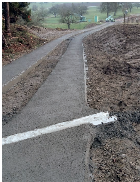
Fertig betonierte Spuren talwärts
