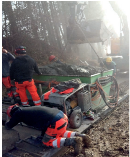
Vom Behälter aus werden 2 Spuren betoniert.
