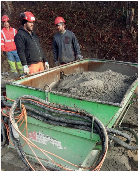
Der Betonbehälter wird gefüllt.
