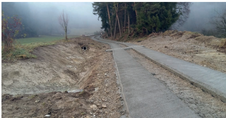
Fertig betonierte Spuren Richtung Reservoir
