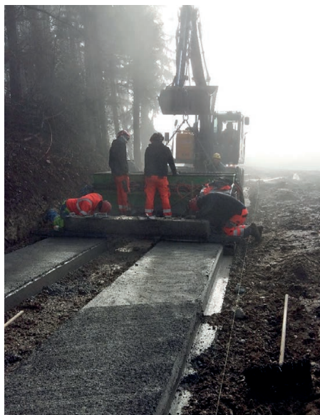
Der Betonbehälter wird mit dem Bagger langsam runter gezogen.
