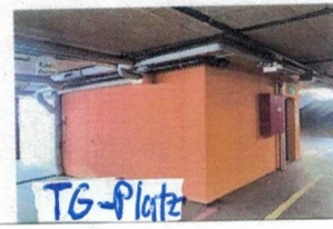
TG-Platz am Treppenhaus nahe Ein-und Ausfahrt
