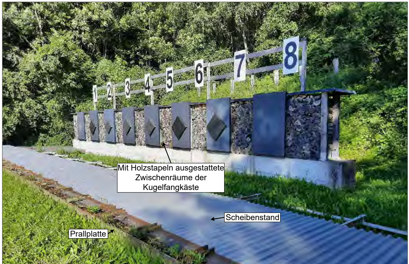
Foto 1: Aktueller Stirnholzstapel, Scheibenstand und Prallplatte
