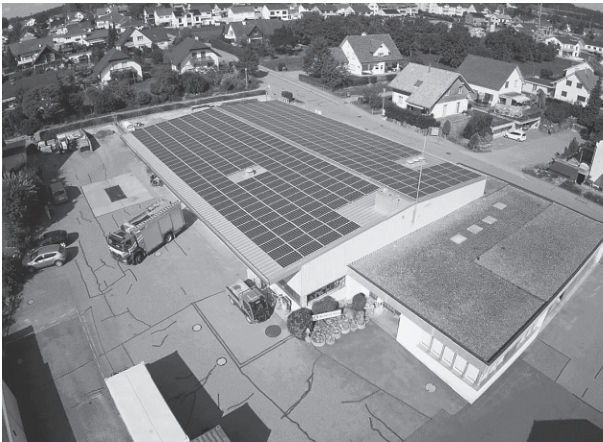
Photovoltaikanlage Werkhof, Berg
