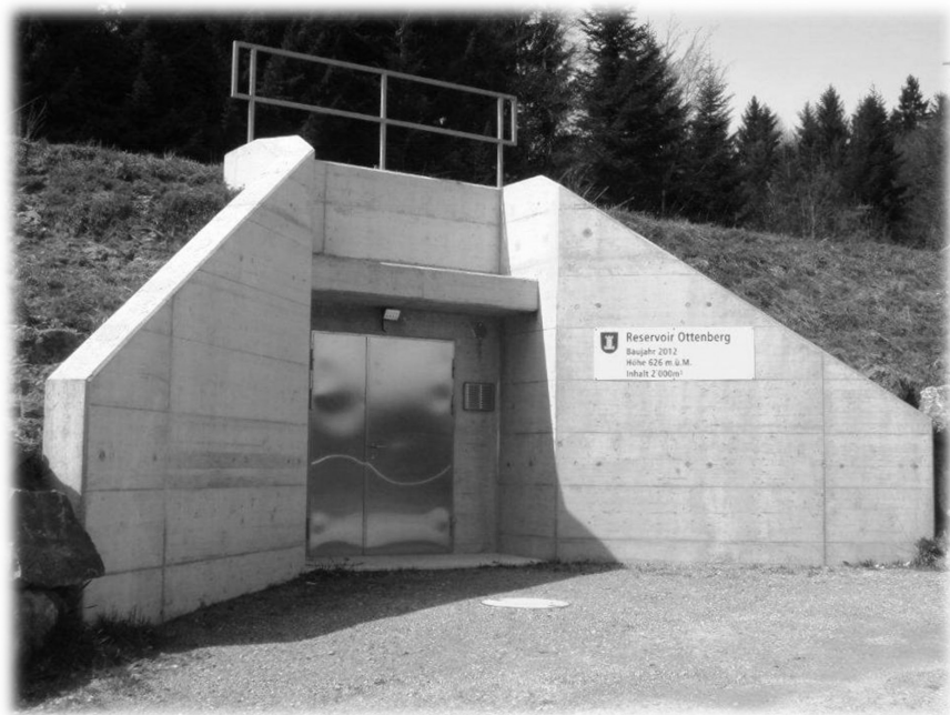
Eingang zum neuen Reservoir Ottenberg
