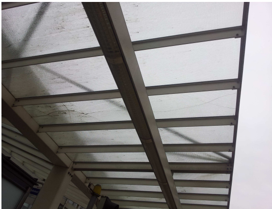
Glasdach: defekte und nicht mehr zugelassene Drahtgläser
