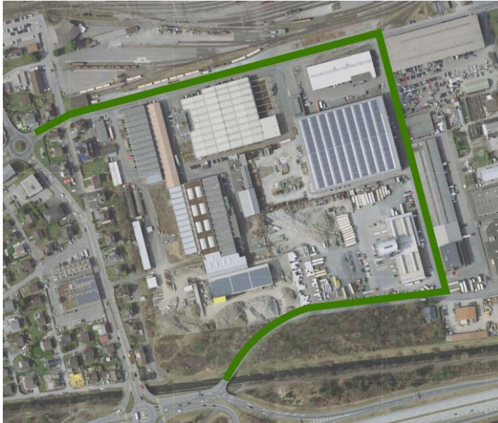
Abbildung 46: Umleitungsstrecke von der Ausfahrt Richtung Buchs
