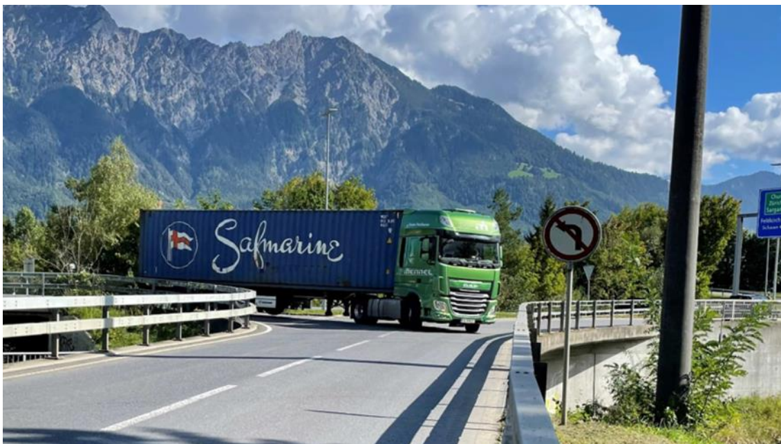
Abbildung 14: Ungenügende Schleppkurve Autobahn rechtsabbiegend in die Langäulistrasse
