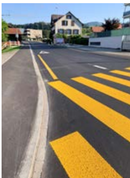
■ Auf der sanierten Ernetschwilerstrasse wurden auch die Bodensignale neu gezeichnet.
