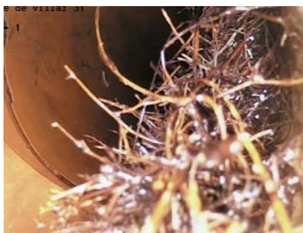
Formation de calcaires et racines retirées des conduites communales
