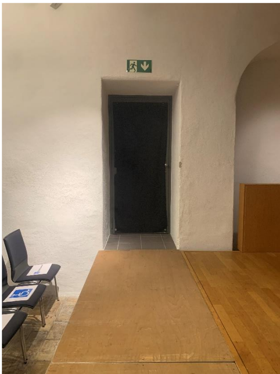
Fluchtweg südseitig Bühne
