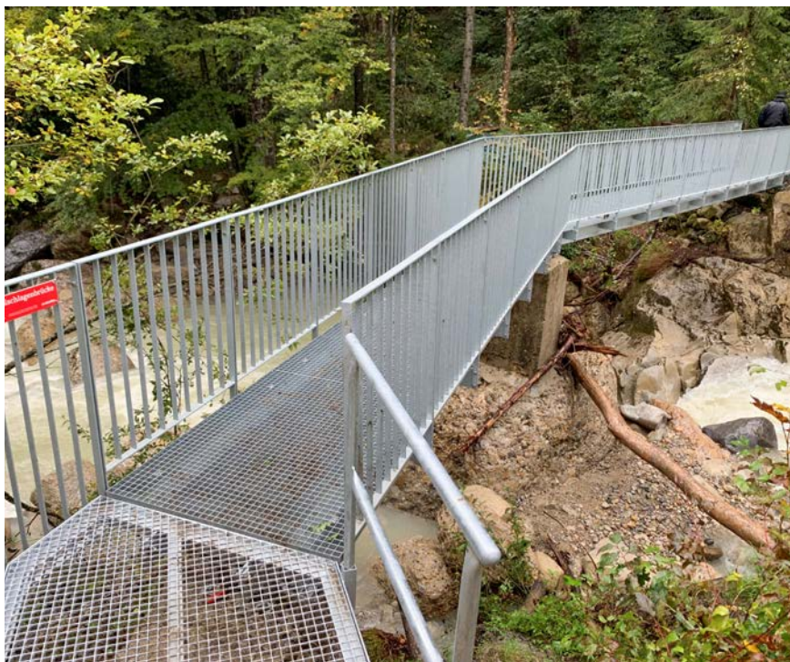
■ Die neue Brücke verbindet Rieden mit Kaltbrunn.
