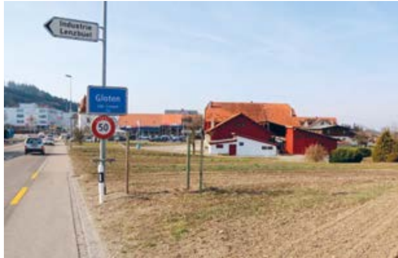
Das Grundstück im Weiler Gloten umfasst 17'000 Quadratmeter und befindet sich direkt an der geplanten Autobahnausfahrt Wil West. Bild: rz
