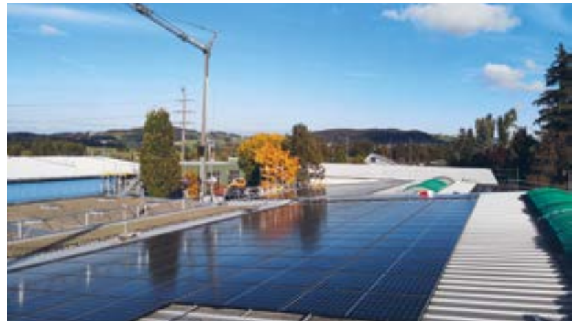
Auf den Dächern Dach des Werkhofs der EW Sirnach AG entstehen die beiden neuen Solaranlagen.
