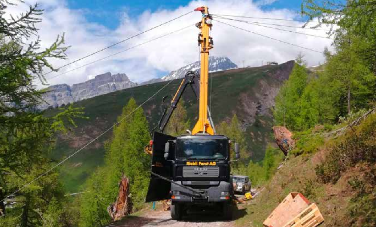
Die Schutzwaldpflege im steilen Gelände, wie im vergangenen Sommer im «Dorbugraben», ist in jeder Hinsicht eine Herausforderung.
