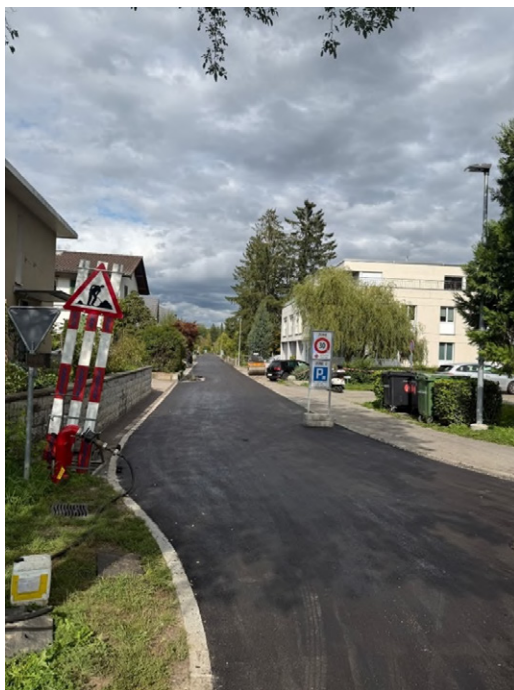
Quelle: Pascale Möri, Projektleiterin Tiefbau, Foto Deckbelag unterer Aareweg
