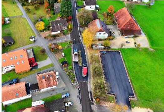
Quelle: Christen Partner Ingenieure und Planer AG, Drohnenaufnahme Belagseinbau Hardern
