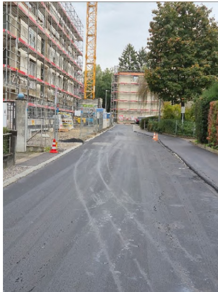
Quelle: Pascale Möri, Projektleiterin Tiefbau, Foto Deckbelag Unterfeldweg
