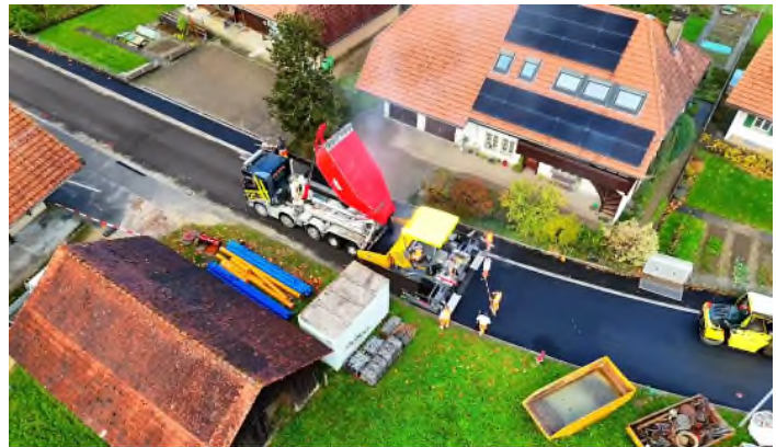
Quelle: Christen Partner Ingenieure und Planer AG, Drohnenaufnahme Belagseinbau Hardern
