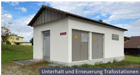
Unterhalt und Erneuerung Trafostationen
