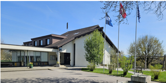
Mehrzweckanlage mit Gemeindeverwaltung
