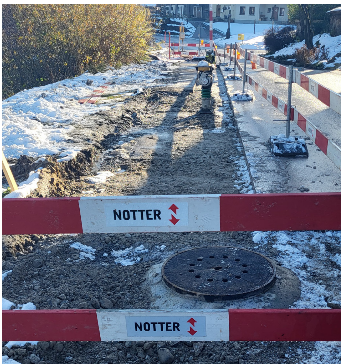
Strassenaufbruch für Kanalisationserweiterung
