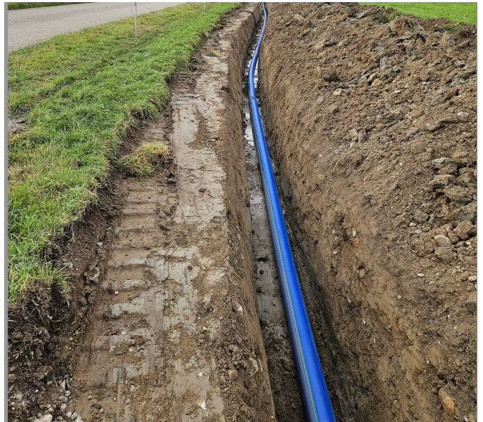
Einlegen der Kunststoffleitung
