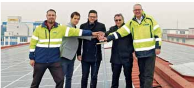
Einweihung der Photovoltaikanlage auf dem Dach der DHL: Daniel Koller, Leiter Elektroinstallation, und Vertreter der DHL; Hagen Pöhnert, Direktor EWB (v. l. n. r.).
