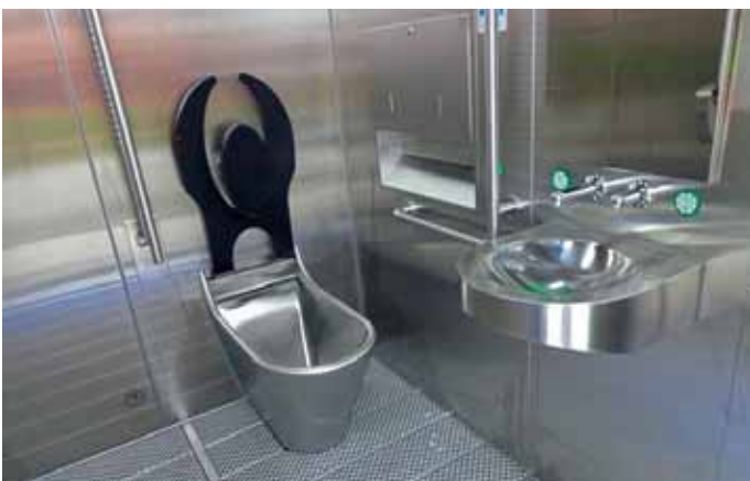
Innenraum der öffentlichen Toilette.
