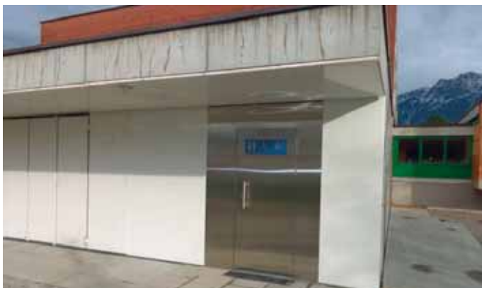
Einbau einer öffentlichen Toilette auf der Schulanlage Hanfland.
