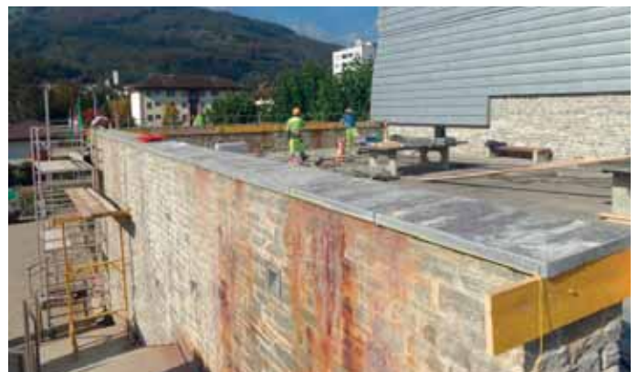
Neue Abdeckplatten aus Calanca-Gneis, welche praktisch gleich aussehen, jedoch nicht rosten.
