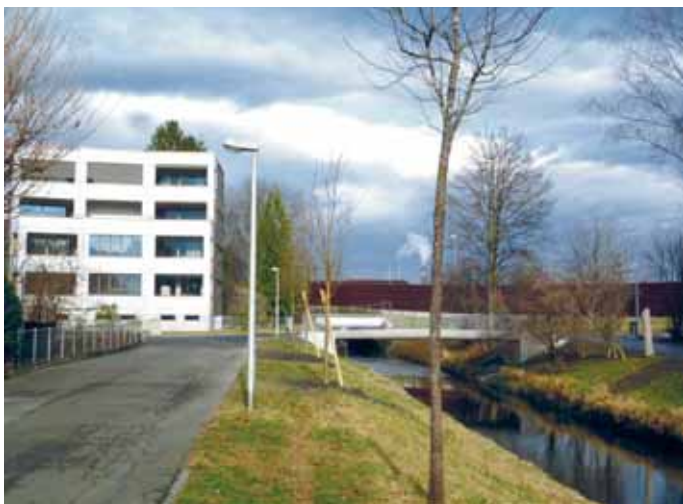
Neubau Brücke Parkstrasse.
