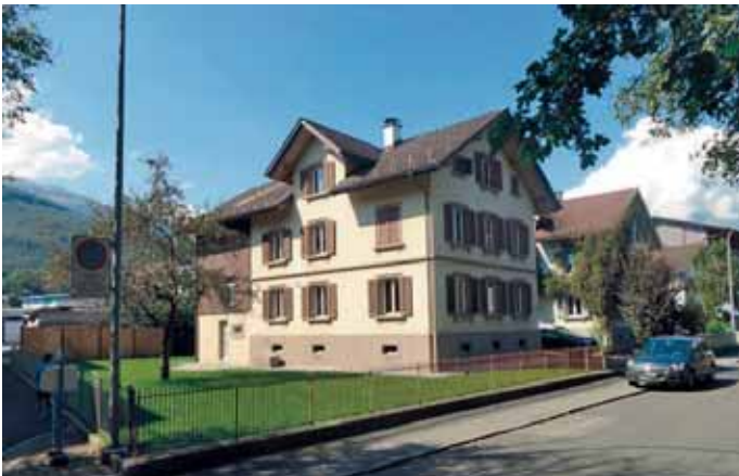
Sanierung der Liegenschaft Volksgartenstrasse 10.
