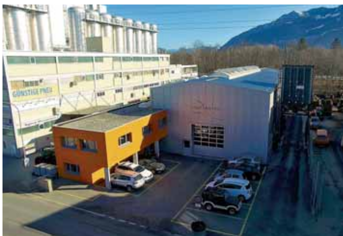
Neubau Personalgebäude und Sanierung der Werkhalle.
