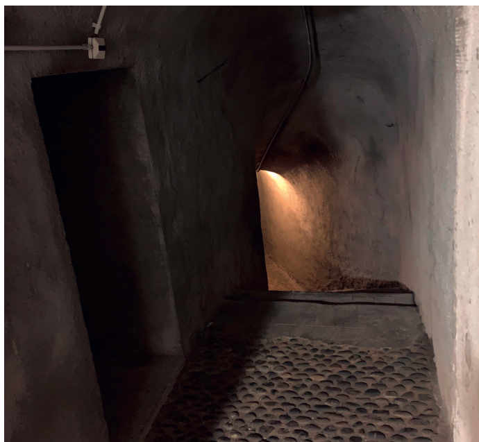
Unter dem Pavillon im Seitenflügel des Schlosses Charlottenfels liegt der Zugang zu einem Gang in Richtung Katzensteig.
