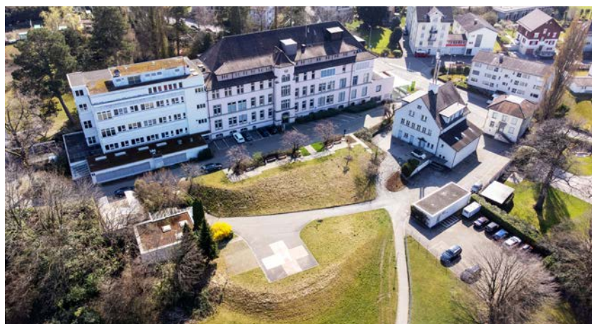
Rosenberg ist das Quartier rund um das ehemalige Spital.
