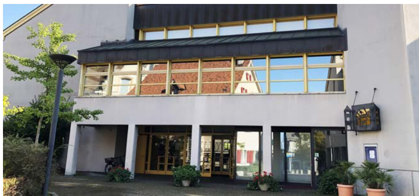
Der jahrzehntelange Betrieb ist nicht spurlos am Stadthof vorbeigegangen: Es stehen grössere Investitionen an.
