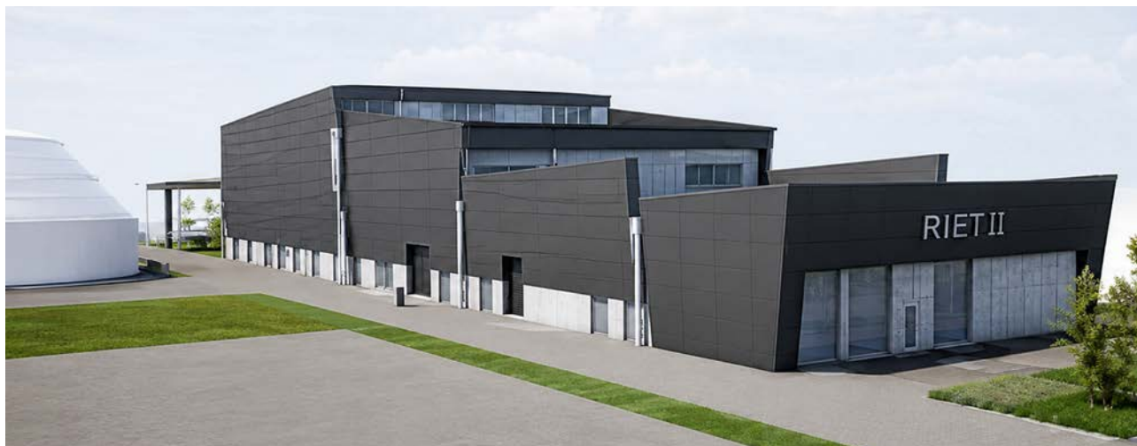
Das neue Seewasserwerk Riet II in Goldach soll in Zukunft das Wasser für die Stadt liefern.
