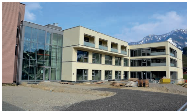
Bald kann mit den Umgebungsarbeiten begonnen werden.
