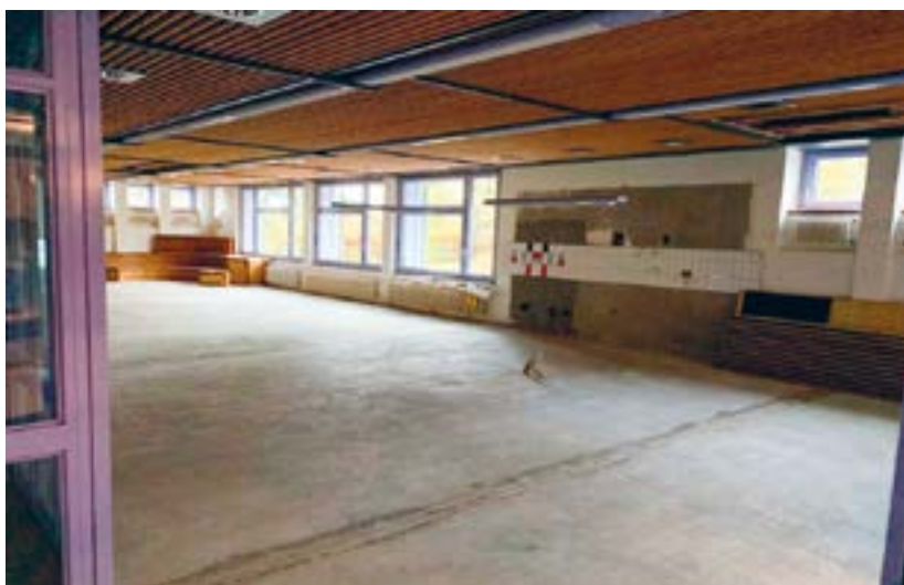
Die Abbrucharbeiten in der ehemaligen Bibliothek sind abgeschlossen.
