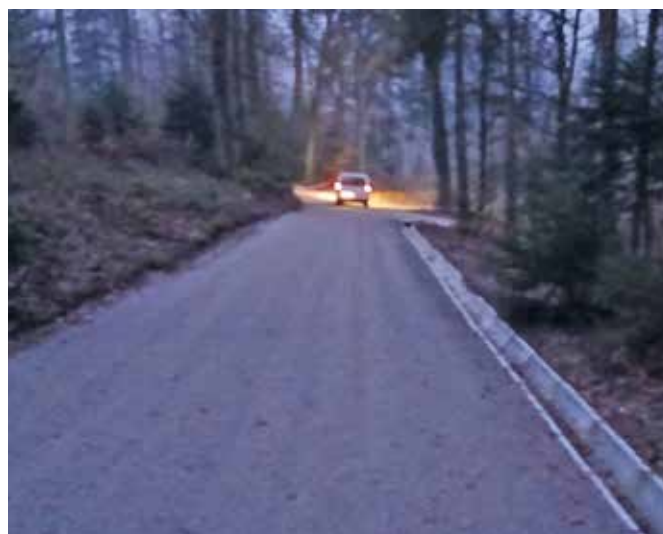
Neue Betonhalbschalen zur Entwässerung der Rosslaubstrasse.
