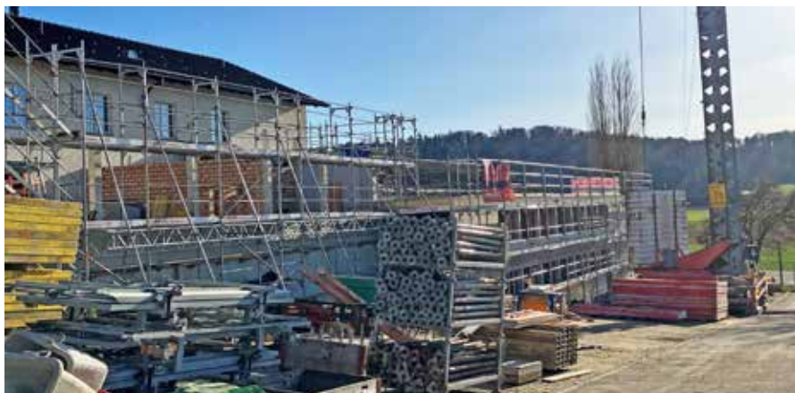
Die Bauarbeiten schreiten zügig voran.
