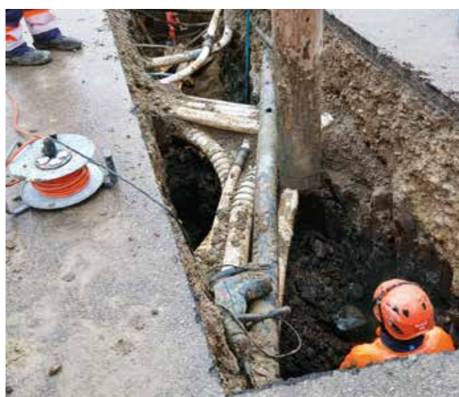
Saugbagger Einsatz und Arbeiten am Regenabwasserkanal in Kirch-Dinhard.
