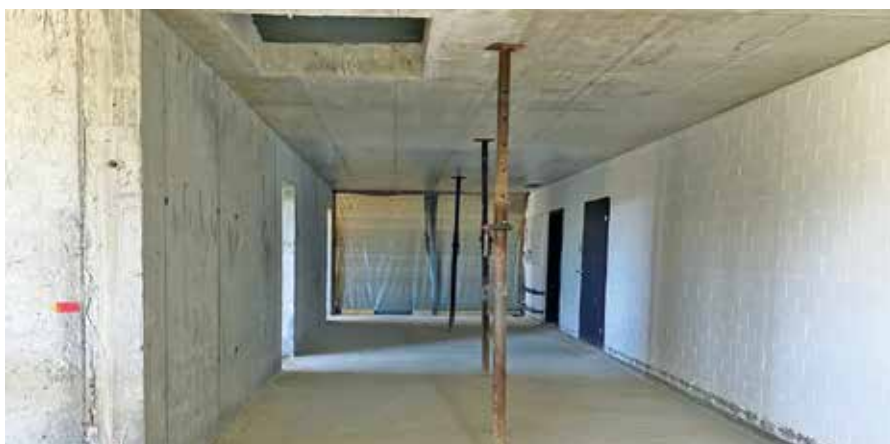
Betonwände anstelle der Fenster (links) zum Parkplatz.
