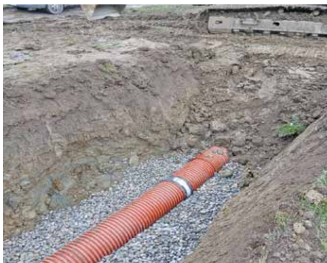
Ersatz der Meteorwasserleitung Mühliwis.
