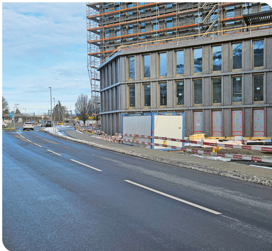
Blick nach Norden auf die sanierte Heldastrasse mit Gehweg (Betonverbundsteine)
