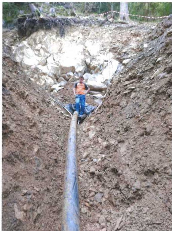
Neufassung der Kluftwasserquelle
