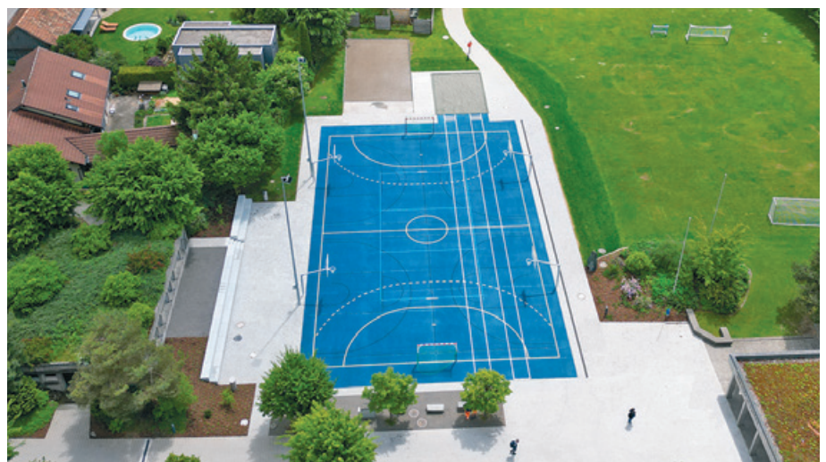
Der sanierte Allwetterplatz der Oberstufe Lerchenfeld.
