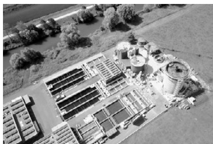
Luftaufnahme Faulturm ARA Obersee
