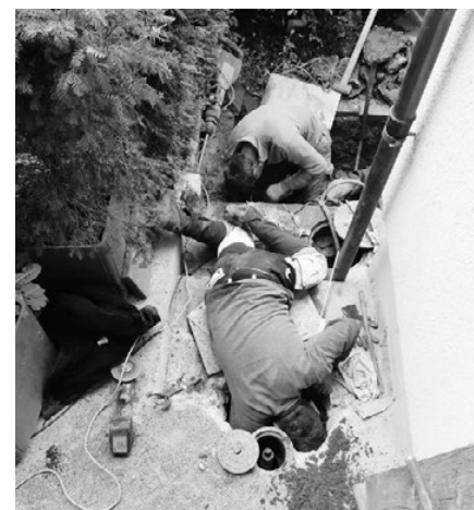
Nicht alltägliche Reparatur einer Wasser-Hauszuleitung
