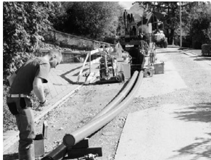
Vorbereitungen für den Leitungsbau im Freudmoos
