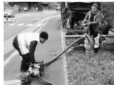
Druck- und Durchflussmessung an einem Hydranten
