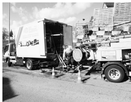
Kanal-Innensanierung aufgrund der Auswertungen von periodischen TV-Aufnahmen
