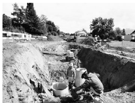
Versetzen von Abwasserschächten an der Ahornstrasse (Neuerschliessung)
