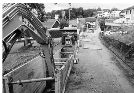
Grabarbeiten für die Kanalsanierung im Freudmoos
