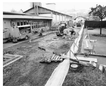
Bauarbeiten im Zusammenhang mit der Strassen- und Werkleitungssanierung an der Brauereistrasse
