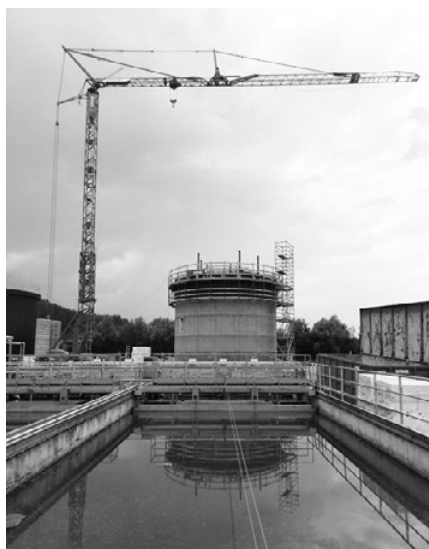
Bau des Faulturms ARA Obersee
