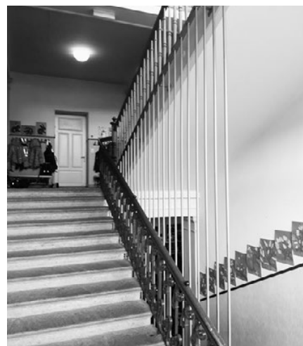
Treppenhaus Schulhaus Letzi
