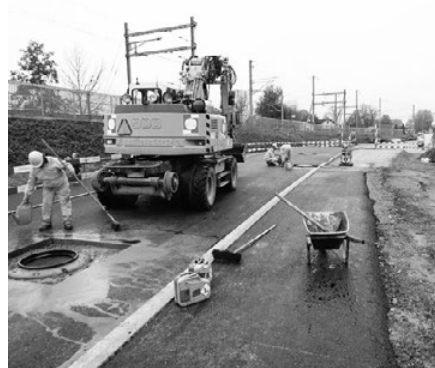
Grossräumige Neuerschliessung für die Überbauung des Seidenweberei-Areals (Seidenhof)
