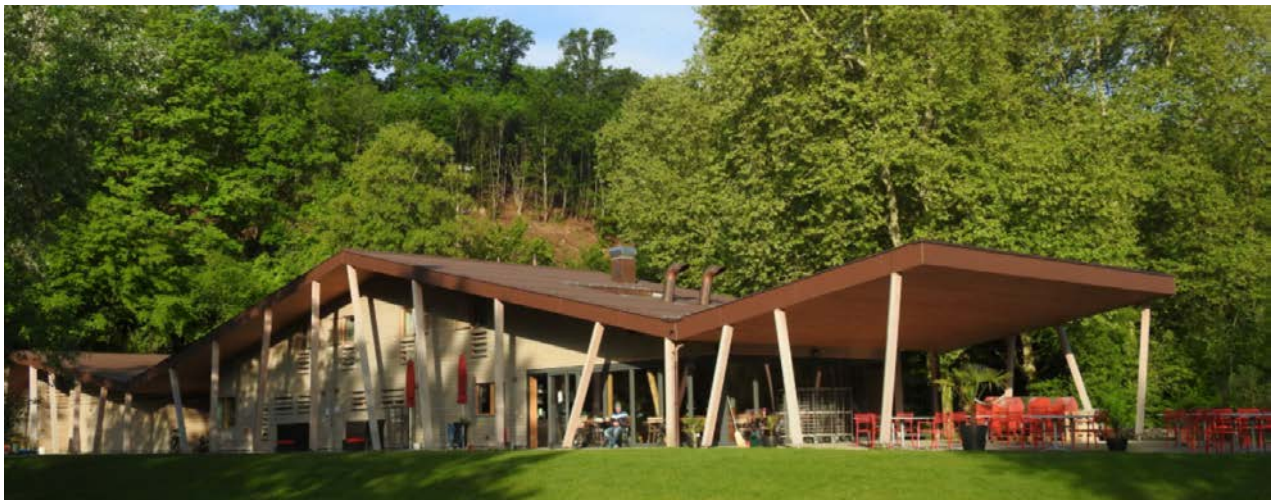
Sanierung und Erneuerung Freizeitanlage Rheinwiese, Abbildung: Bilder Google
