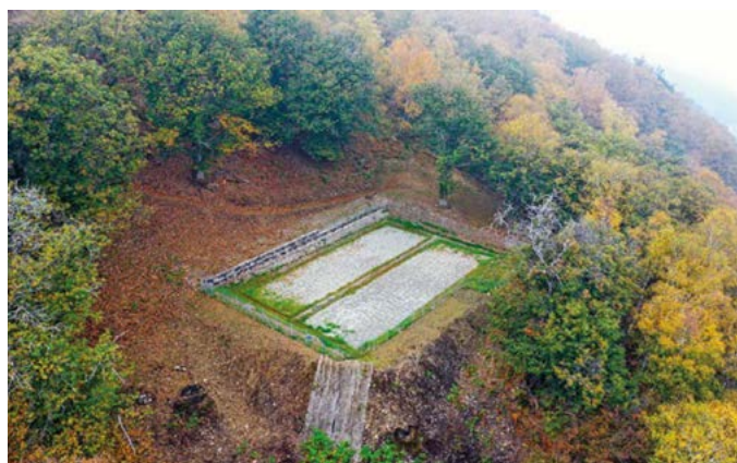
Le vasche di fitodepurazione in località Pianone
