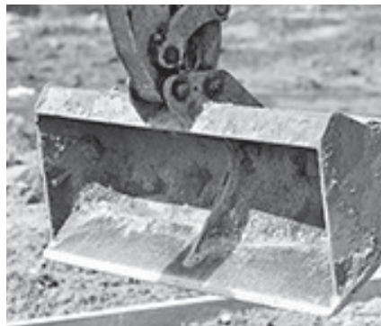
Erdaushub zur Bodenverbesserung verwenden
