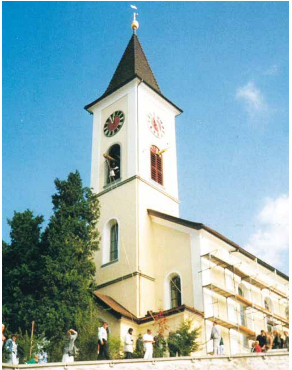
Nach der Renovation erstahlt die Kirche in neuem Glanz. Aufzug der fünften Glocke am 01.10.1989
