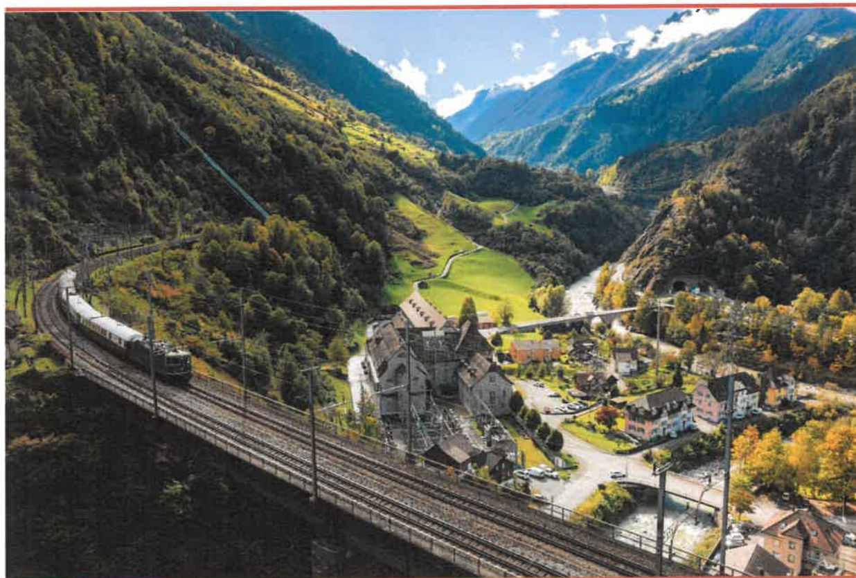
Blick auf Kraftwerk Amsteg
