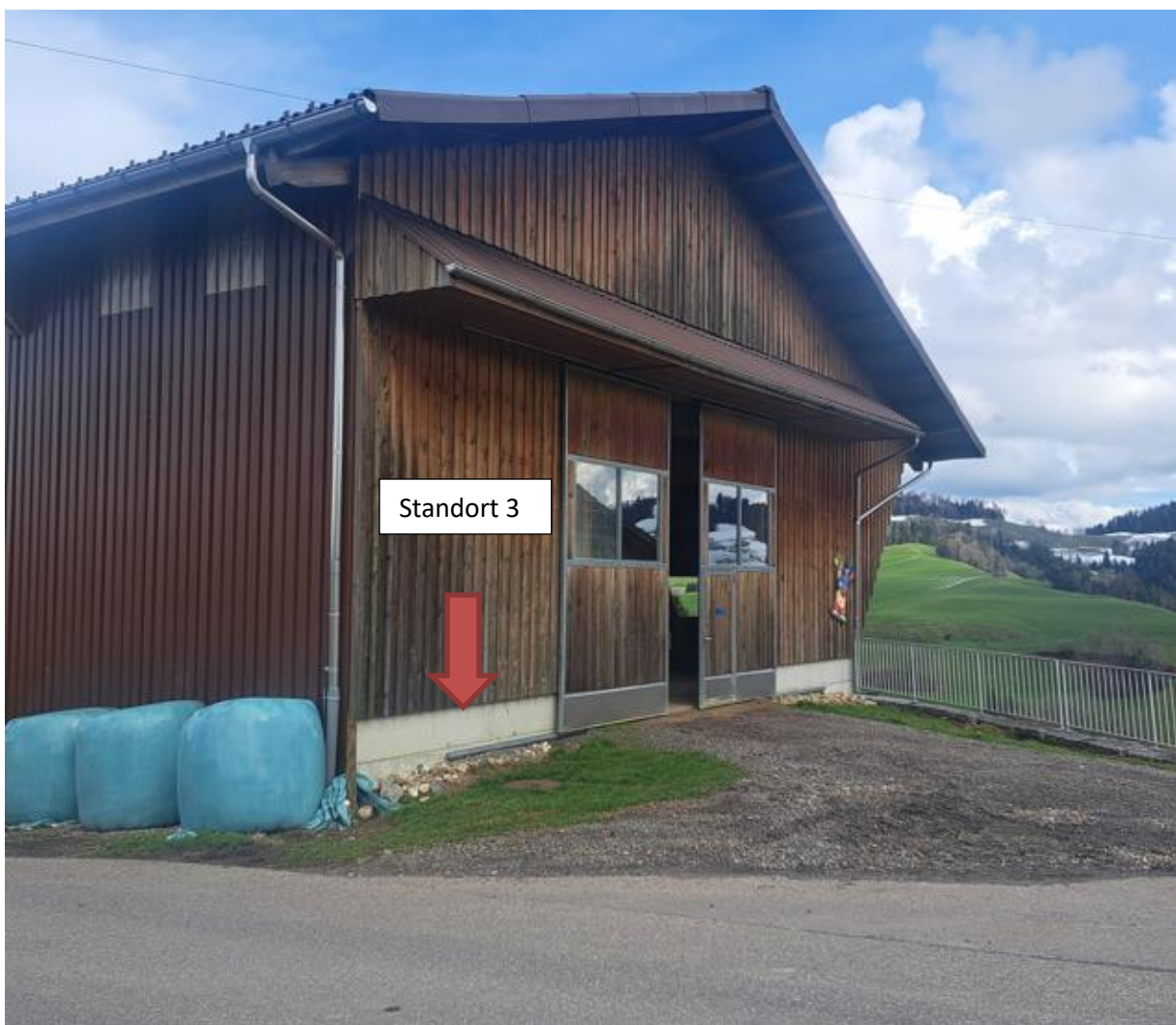
Foto Nr. 5: Standort Oberhalb Scheune Lustenberger
